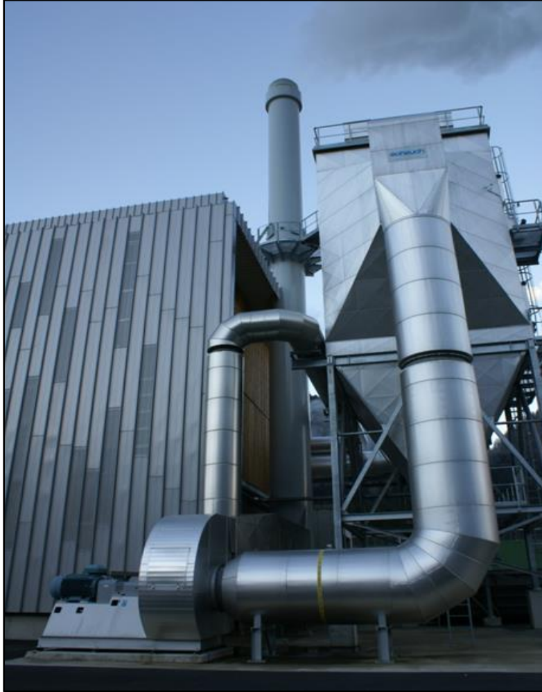
Şekil 16. Örnek Bir Tesisten Emme Fanı ve Baca Sistemini Gösterir Fotoğraf
