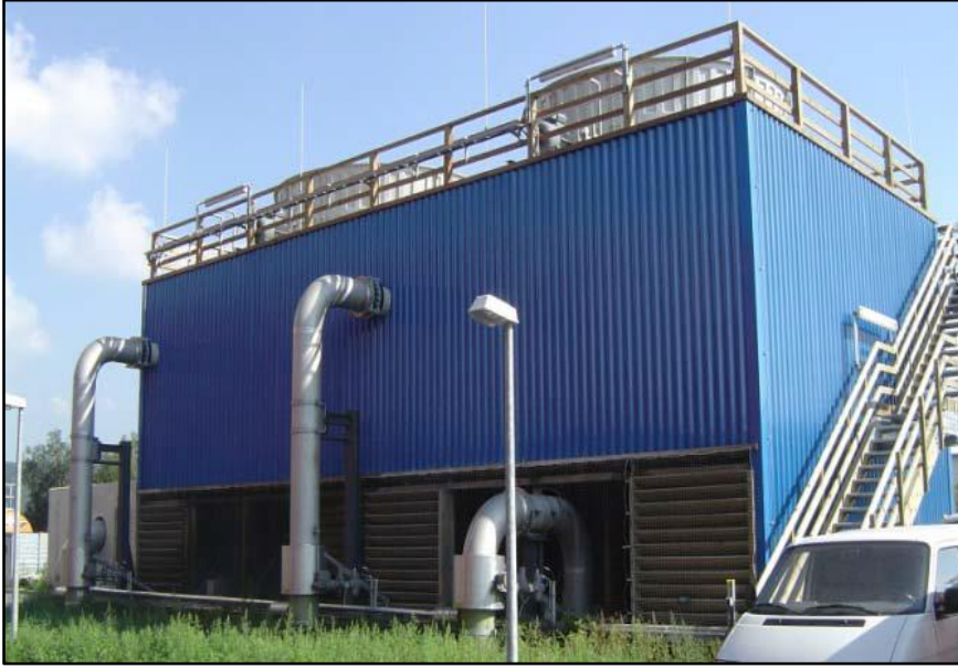
Şekil 15. Islak Tip Soğutma Sistemi
